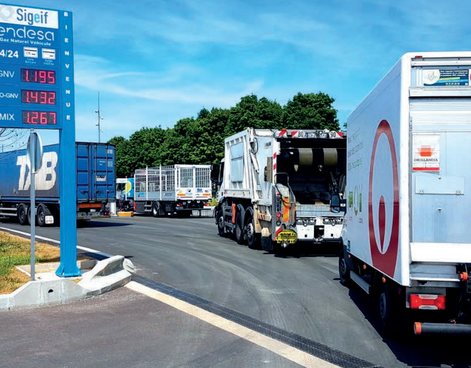
Bonneuil-sur-Marne : la première station GNV/bio-GNV du Sigeif a été inaugurée le 24 novembre 2016. Elle est construite sur une superficie de 4 000 m 2 et son exploitation a été confiée à Endesa.
