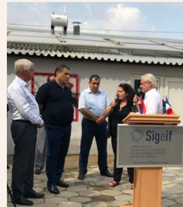
Inauguration par Jean-Jacques Guillet de l'installation photovoltaïque lors de la visite en septembre 2017, en présence du préfet de la région de Tavush.
