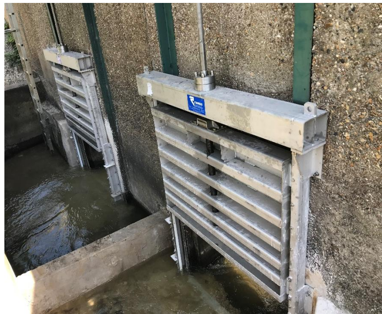
Vanne neuve sur l'ouvrage de Viglénis aval
