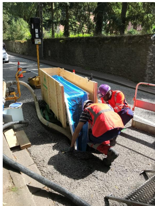
Installation de la gaine lors du chemisage de l'antenne de Bauvinon
