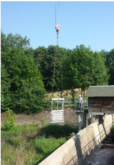
Installation de vanne sur l'ouvrage de Viglénis aval
