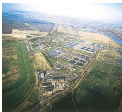
Seine aval (capturée en 2001), l'usine historique qui a depuis été en grande partie rénovée.
