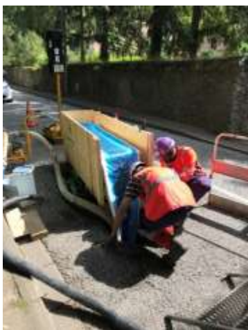
Installation d'une gaine lors d'un chemisage
