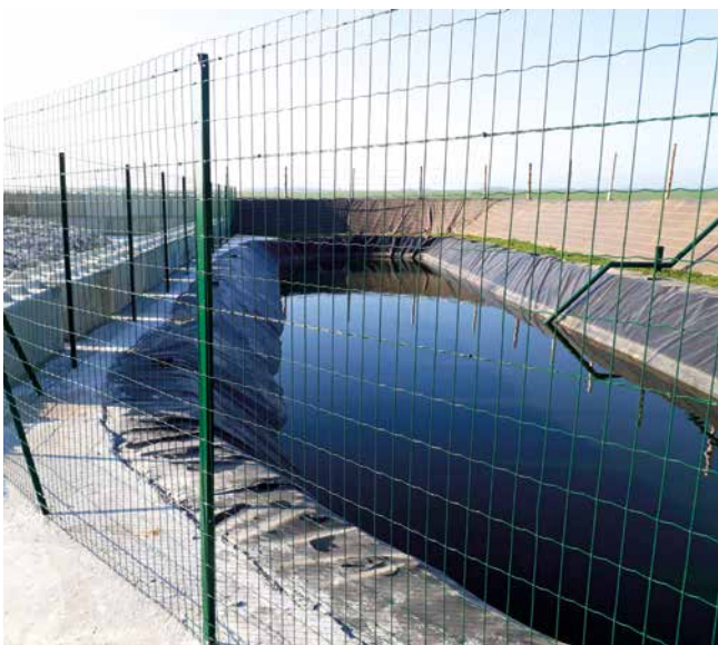
Plateforme de stockage des boues (exemple de Corbreuse – SQY).
