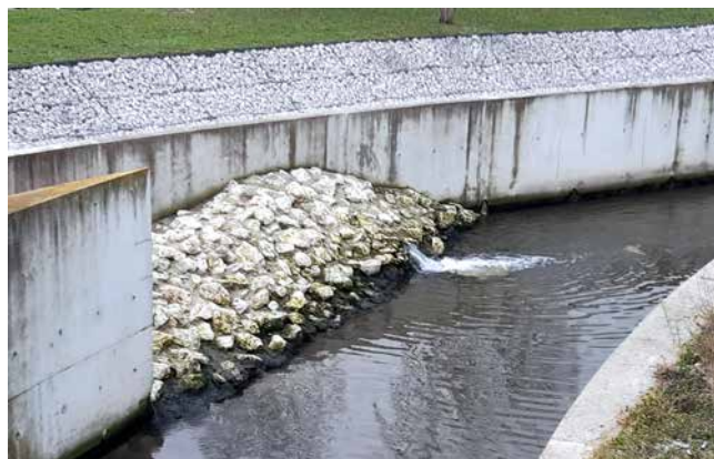
Écoulement du ru de Gally au niveau de la station d'épuration.
