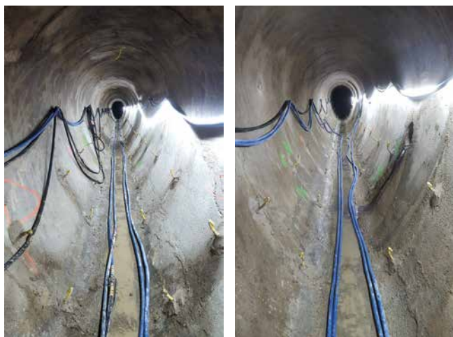
Vue intérieure du collecteur visitable en cours de réhabilitation.
