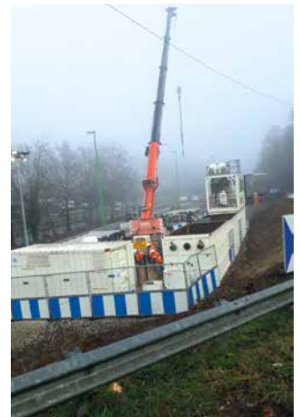
Aménagement de la zone autour du puits de poussée.
