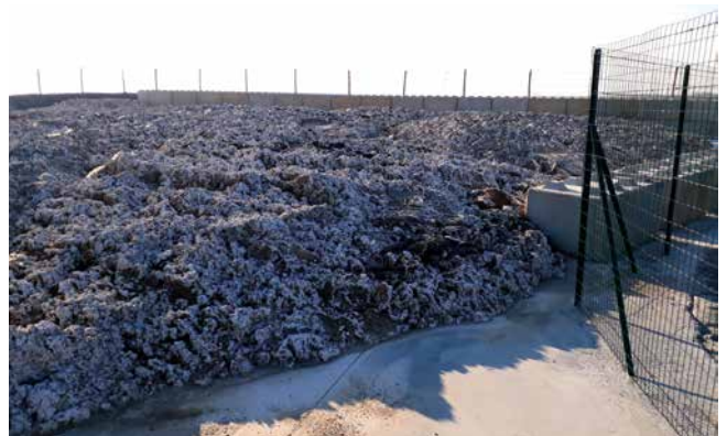
Plateforme de stockage des boues (exemple de Corbreuse – SQY).
