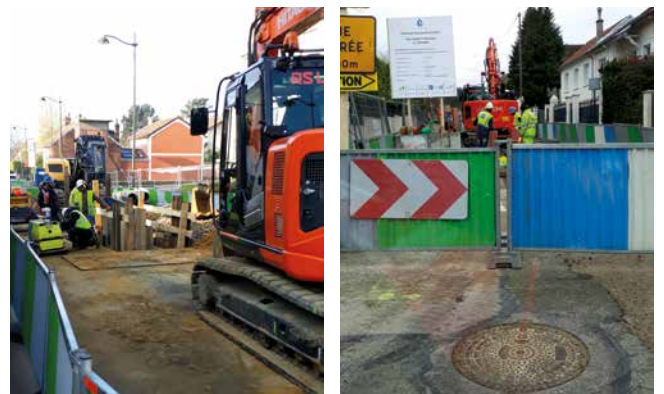
Travaux rue Ernest Psichari au Chesnay-Rocquencourt.
