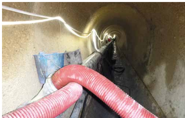
Vue intérieure du collecteur en phase chantier.
