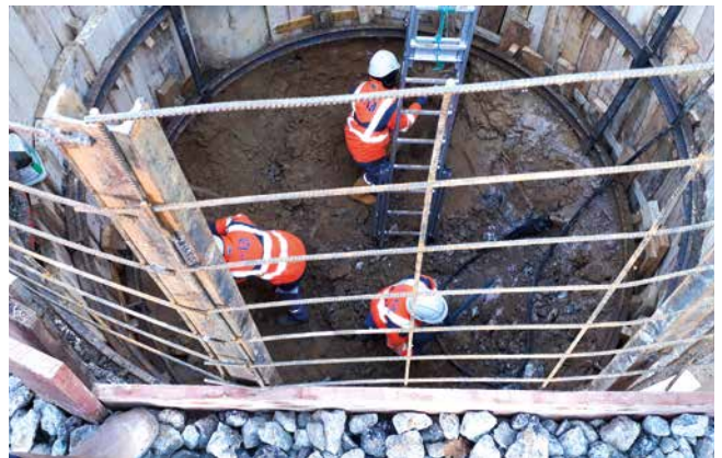
Terrassement du puits de sortie côté Bois d'Arcy.
