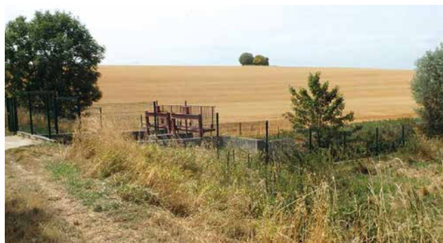
Digue de Rennemoulin.
