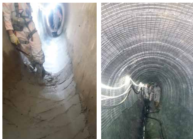
Reconstruction du radier et mise en place des grilles de renforcement avant injection du béton.
