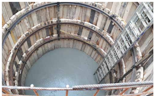
Aménagement du puits de sortie côté Bois d'Arcy.
