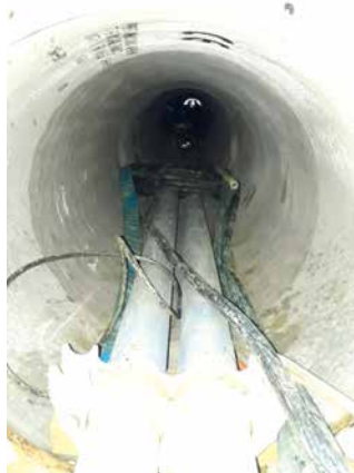
Fourreau en béton en cours de construction.
